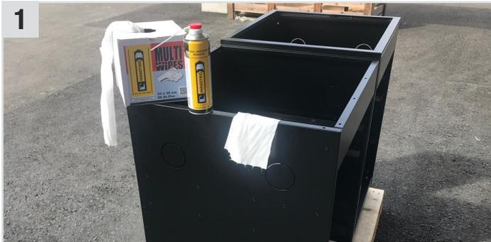
**1** Auflagerahmen und Klebefläche an der Seitenwand mit **Seal and Bond Remover** (Klebstoff- & Dichtmassenentferner) und **Multi Wipes** (Universaltuch) entfetten/reinigen, mit einem sauberen **Multi Wipes** (Universaltuch) trocken reiben und ca. 5-10 Min. ablüften lassen.
