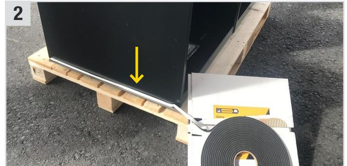
**2** **Sealline** (Schaumklebeband bzw. Abstandsband) an der Auflageschiene am unteren Ende der Seitenwand (Plattenauflegerahmen) anbringen.
