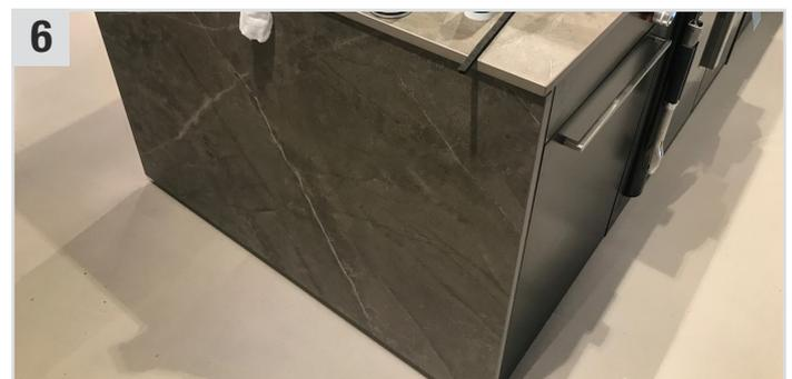
**6** Die Dekton/Granitplatte lose auf die Auflagefläche bzw. direkt auf Sealline (Schaumklebeband bzw. Abstandsband) auflegen und fest an die Seitenwände andrücken.
