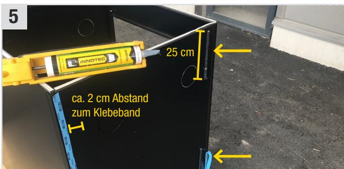
**5** Abdeckfolien entfernen. **Adheseal** (Streichbare Klebedichtmasse) in Kombination mit der **Plastic Nozzle V-Form 8 x 8** mit jeweils 2 Raupen links und rechts, in einem Abstand von ca. 2 cm zum Moulding Tape und in einer Länge von 25 cm senkrecht anbringen.
