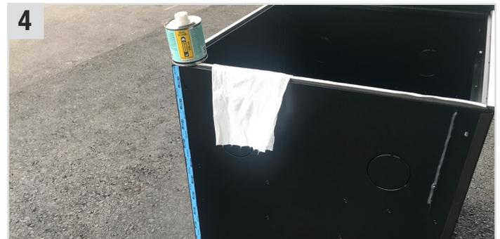
**4** **Seal Guard** (Transparenter Primer) mithilfe eines **Multi Wipes** (Universaltuch) in einer dünnen Schicht an entsprechender Klebestelle auftragen und ca. 15 Min. ablüften lassen.
